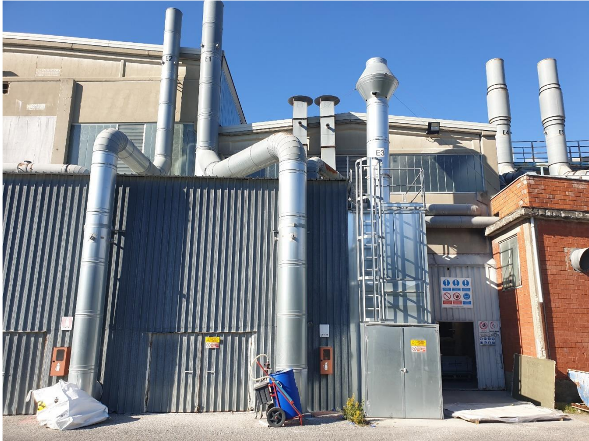
Foto 5 – Prospetto capannone E e adiacenti impianti
