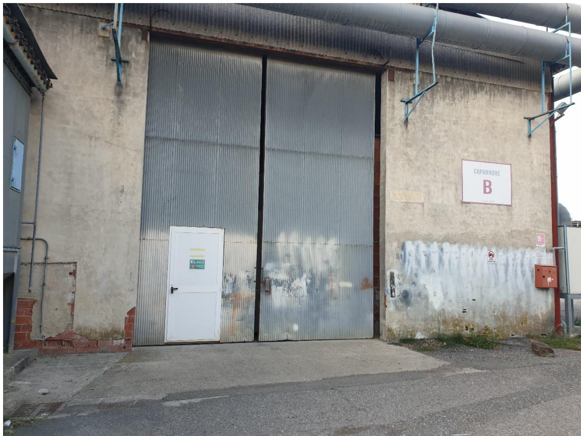
Foto 6 – Prospetto Capannone B
