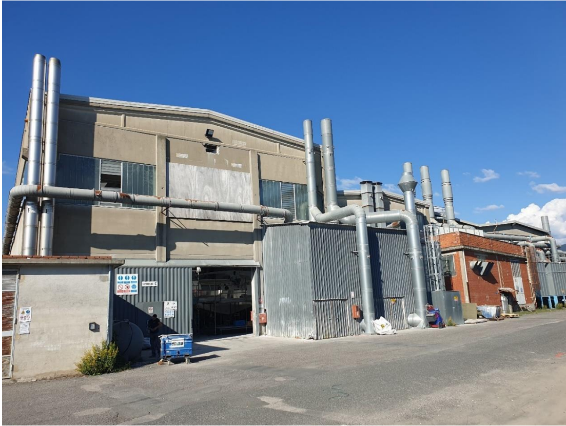
Foto 1 – Capannoni C, E, A - Prospetto sud con annessi locali tecnici e impianti
