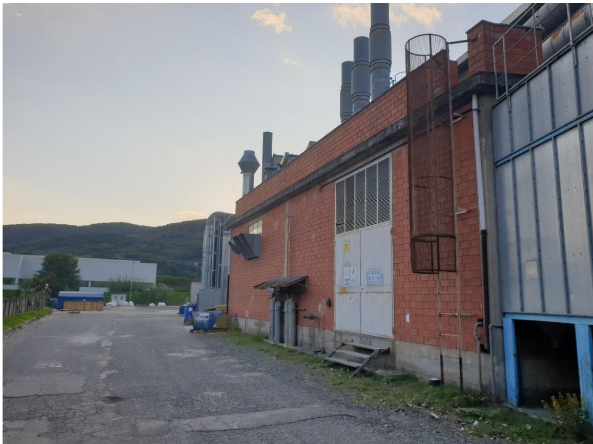
Foto 2 – Locale tecnico con tamponamento in mattoni
