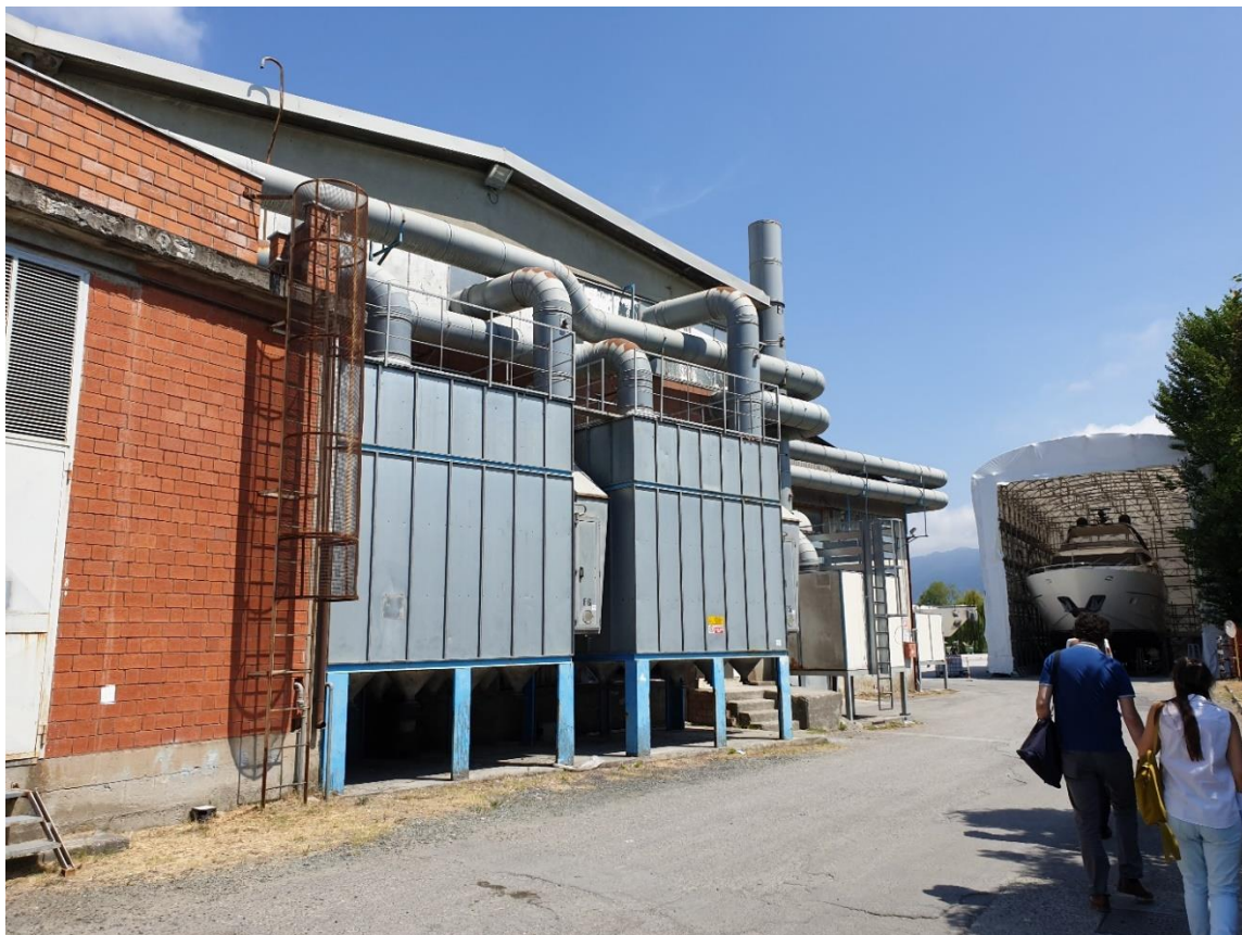
Foto 4 – Prospetto capannone A e B e adiacenti impianti
