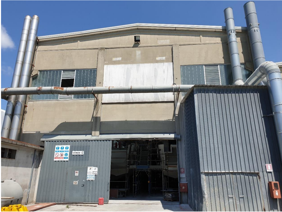
Foto 3 – Prospetto capannone C
